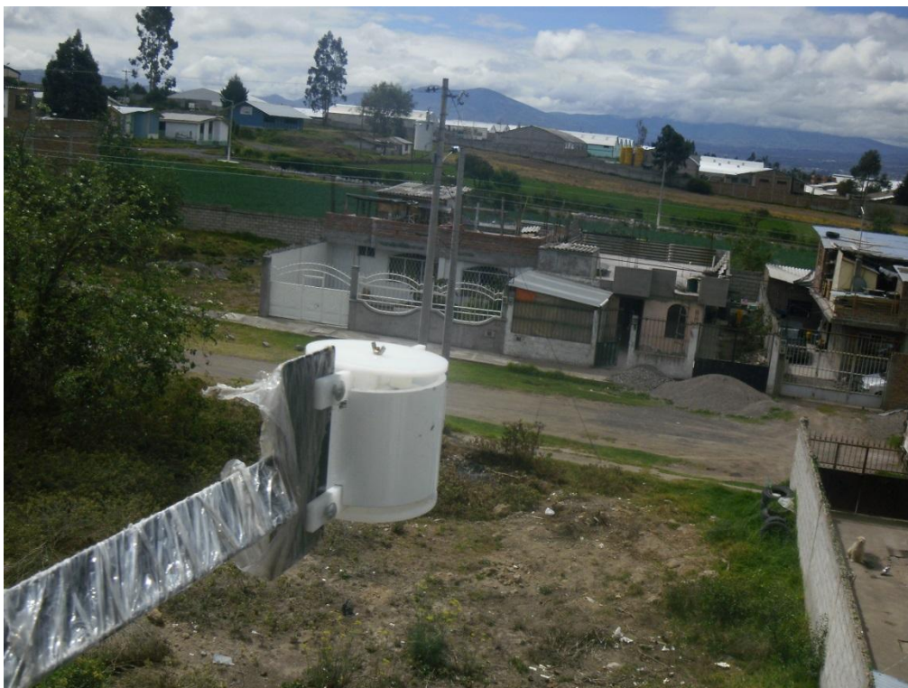
Fotografía 12. Parque Industrial Ambato
