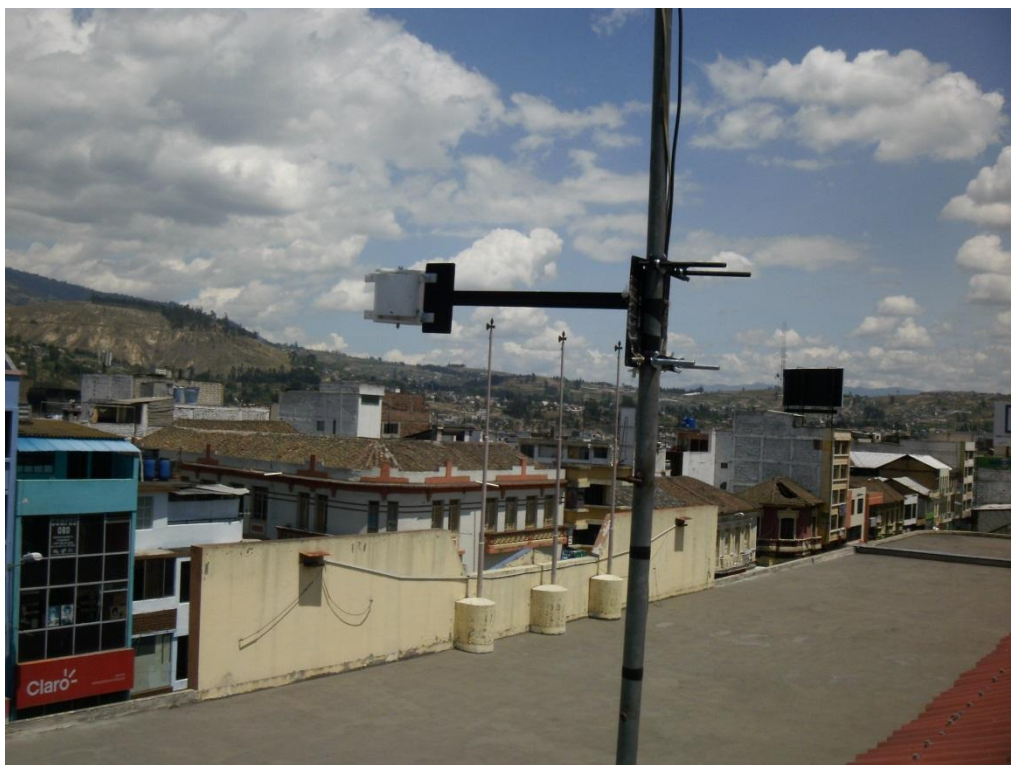
Fotografía 7. Estación San Francisco
