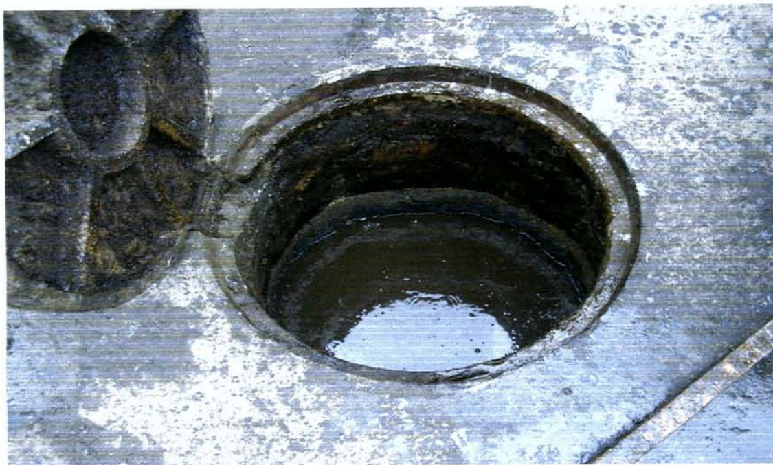
Nº 6 CAJA DE REVISION DOMICILIARIA COLAPSADA
