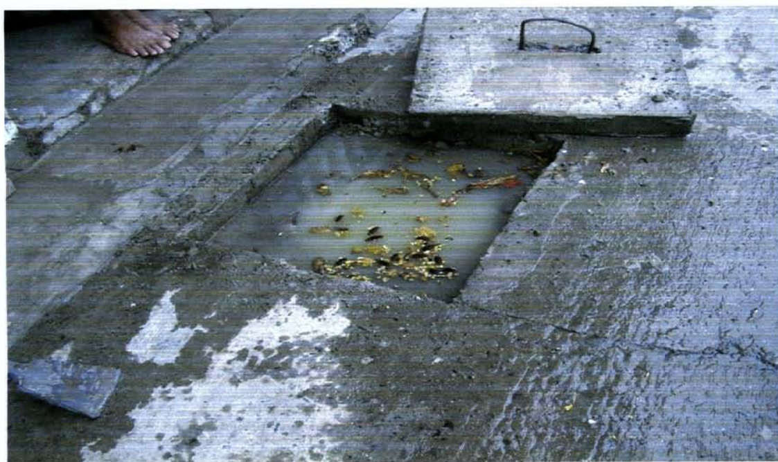
Nº 6 CAJA DE REVISION DOMICILIARIA COLAPSADA
