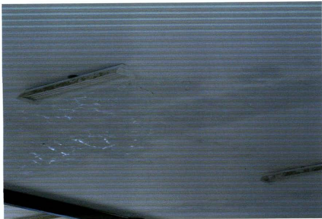
Nº 9 TECHO CON FILTRACIÓN DE LA ESTACIÓN DE BOMBEO MIRAFLORES
