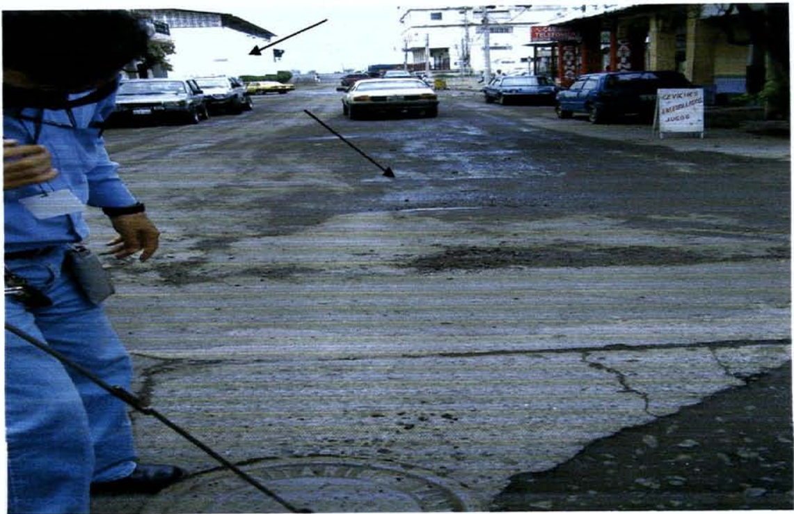
Nº 4 POZO COLAPSADO (CALLE 4 y Av. 11)
