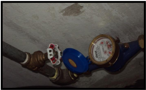
Figura 29. Medidor de Agua de Alimentación
