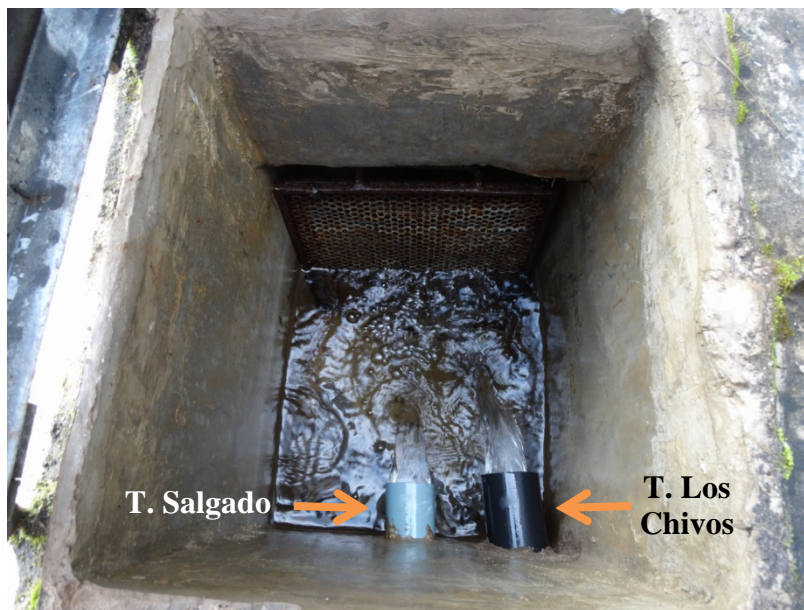
Gráfico 8: Entrada de agua al tanque de cloración
