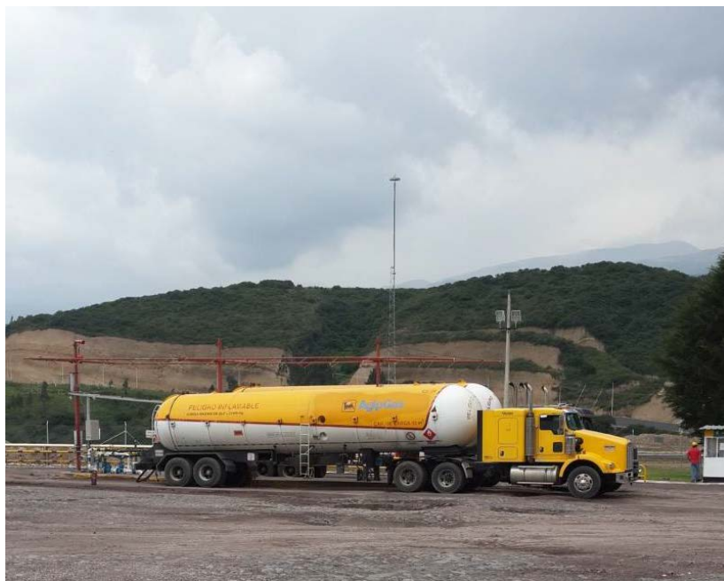
Figura N°2: Isla de Carga y Descarga de Autotanques
