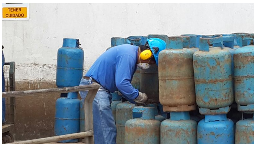
Figura N°8: Colocación de Pinza para desalojo de Gas Residual
