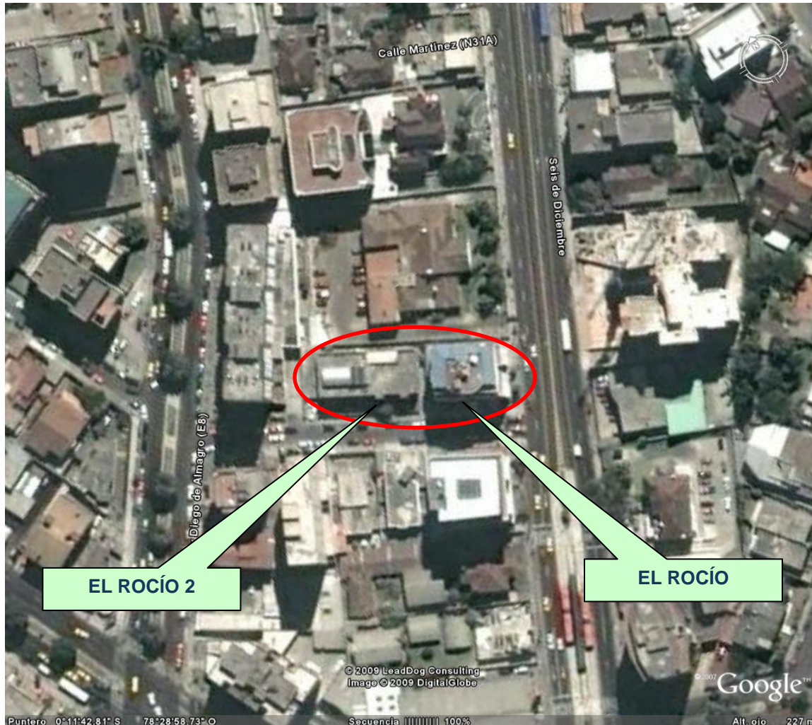
Imagen 5-2 Vista aérea de los edificios El Rocío I y El Rocío II
