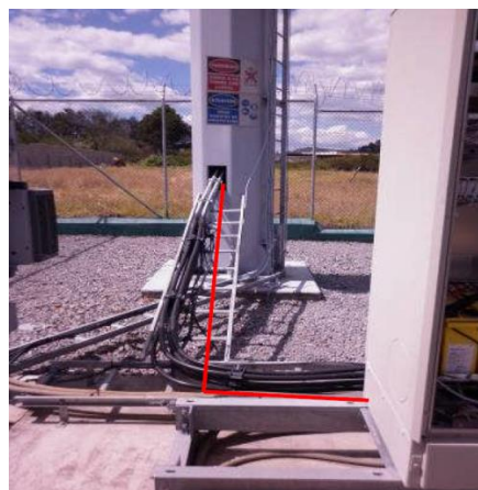
Figura 38. Recorrido del cable de IF por las escalerillas
