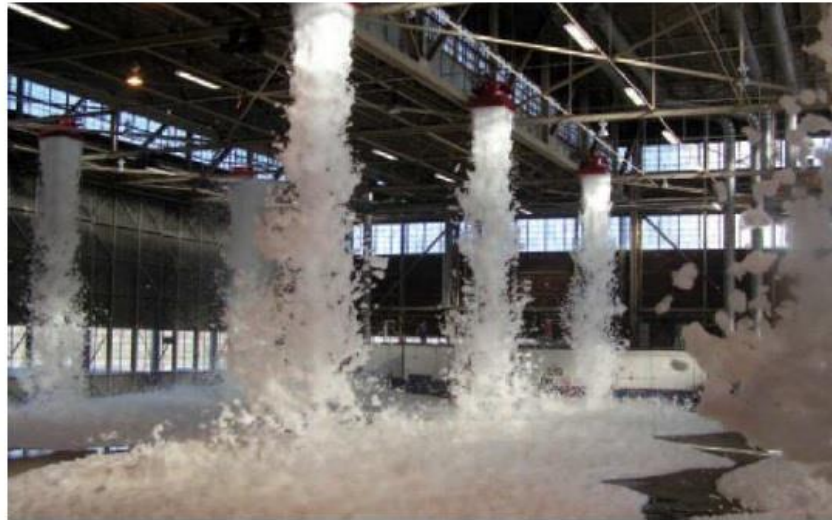
Figura 11.52. Sistema de inundación de una nave industrial en funcionamiento.
