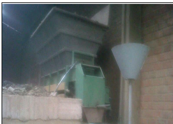
Figura 19: Incorporación del material al proceso de dosificación. (Autor).
