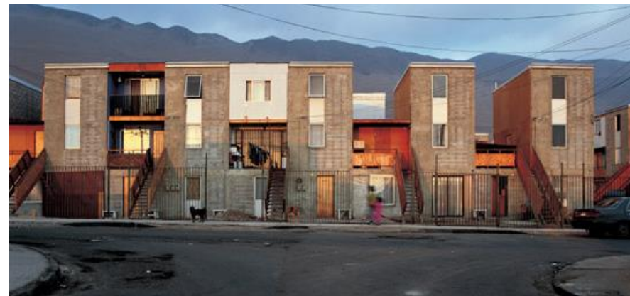
Imagen No.25 Proyecto Quinta de Monroy– Vista del proyecto final y habitado
