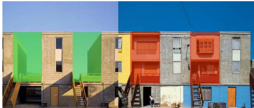
Imagen No.27 Crecimiento de las viviendas en la Quinta de Monroy a través de los años
