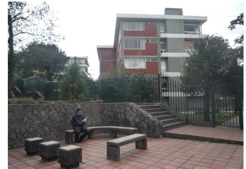
Imagen No.50 Fotografía a las áreas comunales de la Urbanización La Granja - Conjunto No.2
