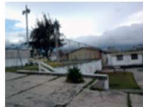
Jardines en deterioro
