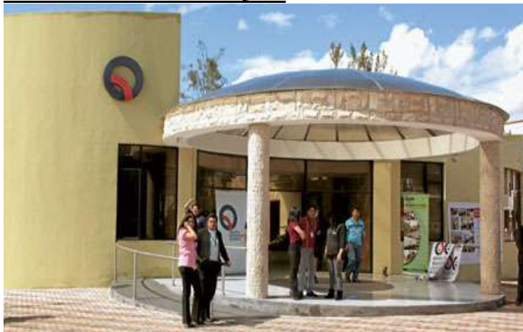
Imagen N° 17 : Centros Comunitarios en Quito
