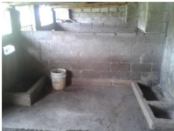
Imagen 3: Interior de las chancheras.
