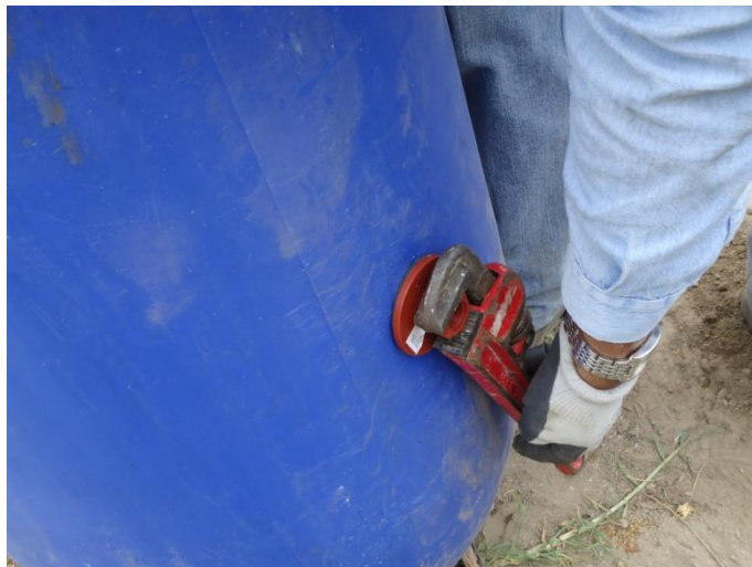
Anexo F3. Instalación de manómetro.
