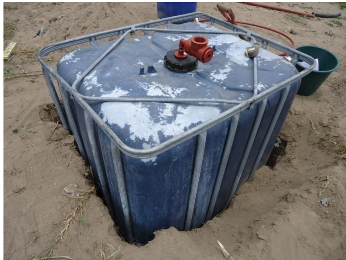
Anexo E2. Instalación del reactor.
