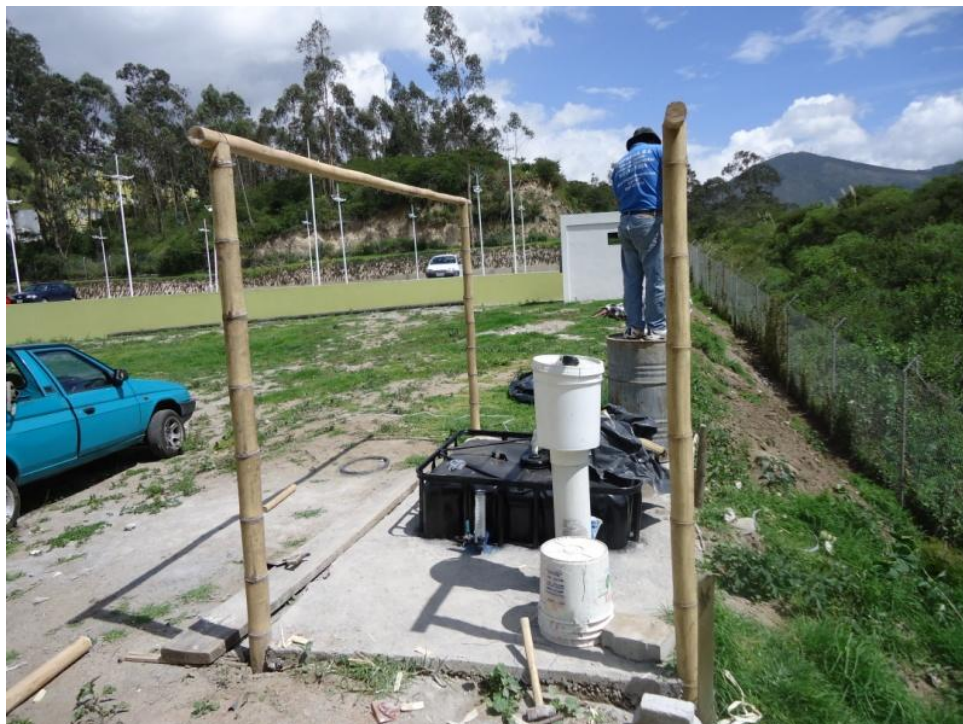
Anexo G1. Instalación de soporte para cubierta.
