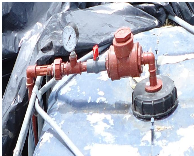
Anexo F3. Instalación de manómetro.
