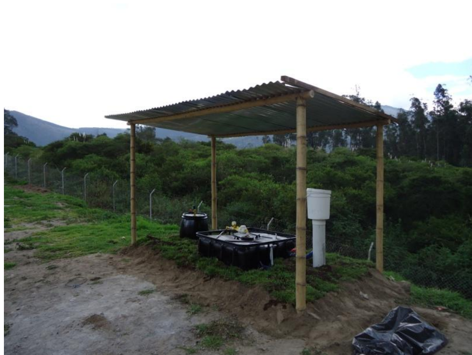
Anexo G2. Colocación del techo y césped.
