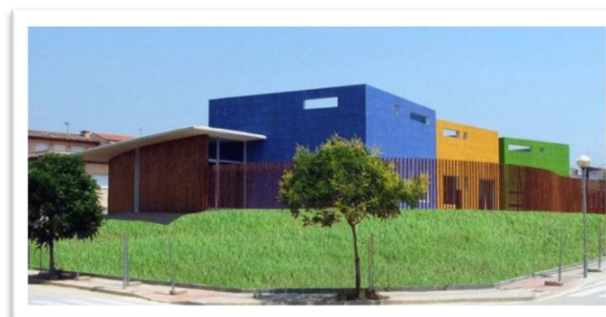
Imagen 31: Guardería Municipal ELS DAUS, Recuperado de: http://www.construible.es/
