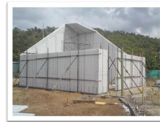
Imagen 46: Muros portantes, Recuperado de: (arquitectobra.blogspot.com)
