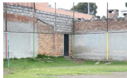
La puerta de acceso. Desde la guardería, los niños van directamente al parque, lo cual es criticado por los moradores.
