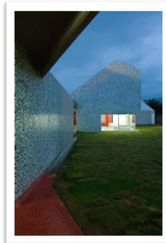
Imagen 50: Patio externo, Recuperado de: (arquitectobra.blogspot.com)
