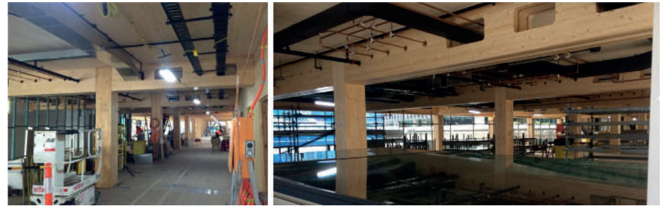
Vigas in situ durante la instalación de los servicios
