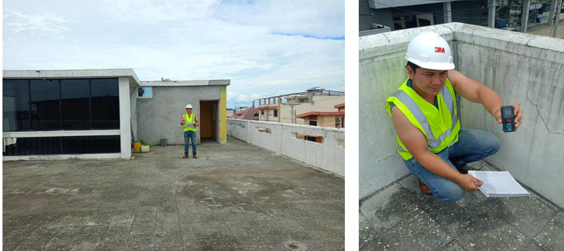
Figura 18 Toma de datos de todo el borde de losa
