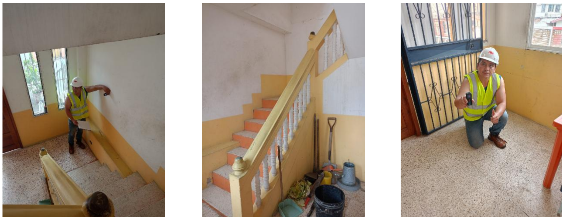
Figura 16 Toma de datos agujero de la grada
