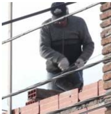
Figura N° 10: Cercanía de trabajos de la construcción al cableado eléctrico
