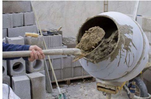
Imagen 10: Mezclado de hormigón.
