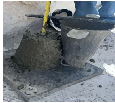
Prueba de asentamiento
