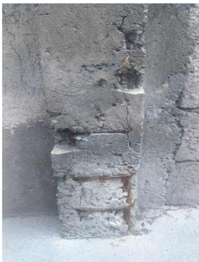
Figura 22. Detalle del armado de una columna existente para su respectiva verificación.
