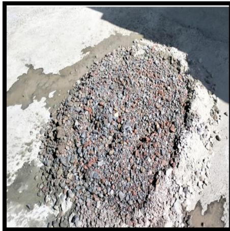
*Mezcla de los materiales para el hormigón sin fibra*
