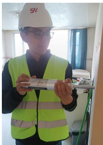
Figura 25.- Aplicación del ensayo de esclerómetro
