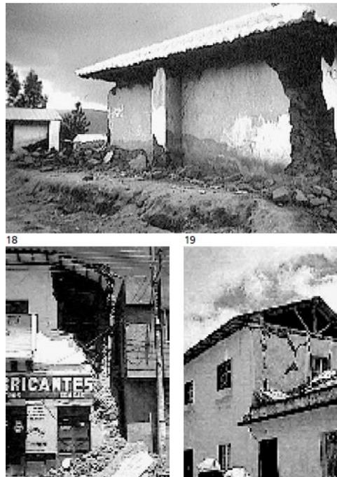
Nota: en la presente figura se puede observar la representación de muros con aberturas, ya sean de puertas o ventanas. (Fuente: (Moran, 2003))
