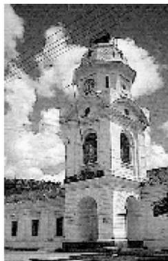
Nota: en la presente figura se puede observar la representación de una torre no esbelta como muros anchos. (Fuente: (Moran, 2003))
