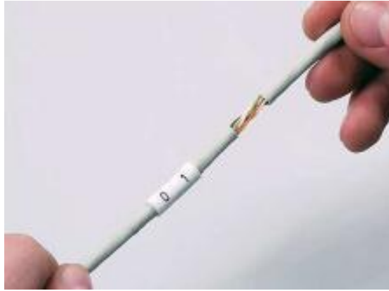
Figura. 4.7 Remover la chaqueta del cable UTP
