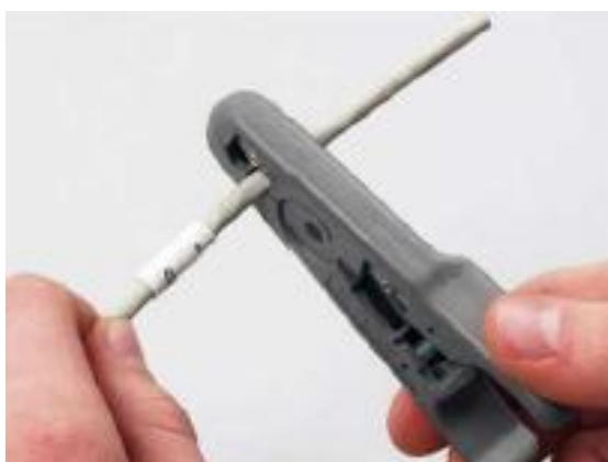
Figura. 4.12 Corte de chaqueta en el cable UTP
