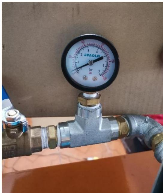
*Nota. Presión de funcionamiento de la bomba.*
