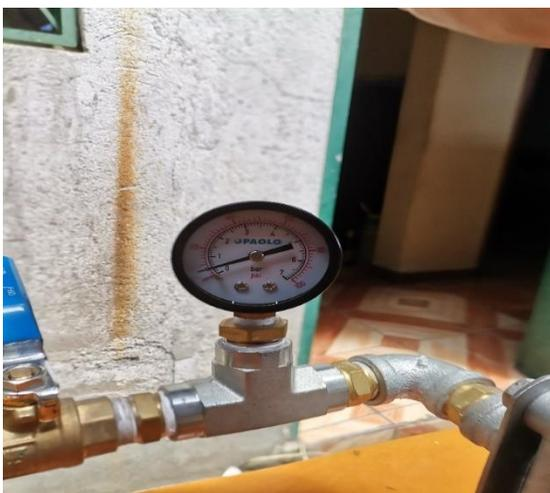
Manómetro de presión en el sistema de refrigeración 0,2 bar
