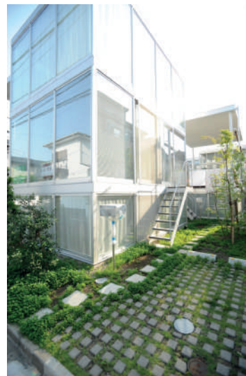
Foto 45 Patio - Shakuji Apartments Fuente: https://proyectos4etsa.wordpress.com/2018/06/22/apartamentos-shakuji-2009-2011-sanaa/
