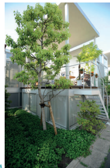
Foto 46 Jardines - Shakuji Apartments Fuente: https://proyectos4etsa.wordpress.com/2018/06/22/apartamentos-shakuji-2009-2011-sanaa/
