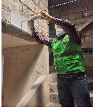
Figura No. 44. Ensayo de esclerómetro en losa.
