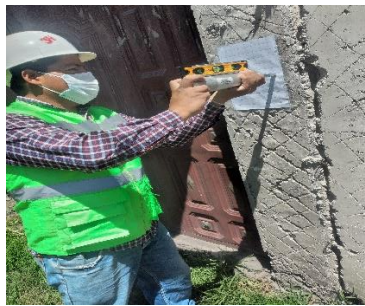
Figura No. 42. Ensayo de esclerómetro en columna.
