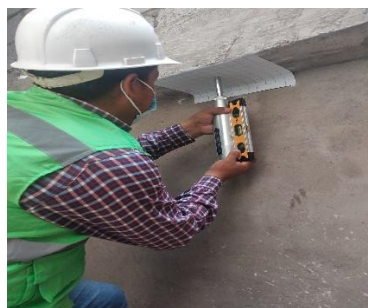
Figura No. 43. Ensayo de esclerómetro en viga.
