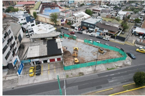
Vista aérea del terreno desde la Avenida América
