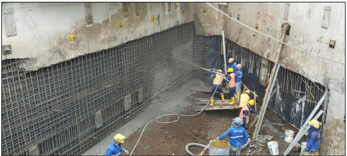
*Fotografía 2, Proyección de Hormigón 280 Kg/cm<sup>2</sup>, proyecto de construcción Centro Médico Atlas*
