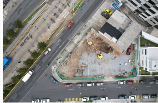
Vista superior del predio después de los trabajos de demolición.
