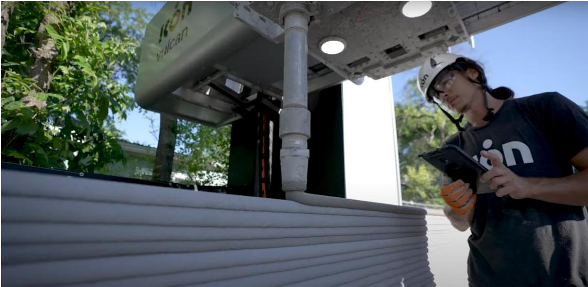
*Nota: La Figura 5 muestra parte del proceso de construcción de la pared de una casa creada con ayuda de una la tecnología de impresión 3D (Sarah Romero, 2022)*
