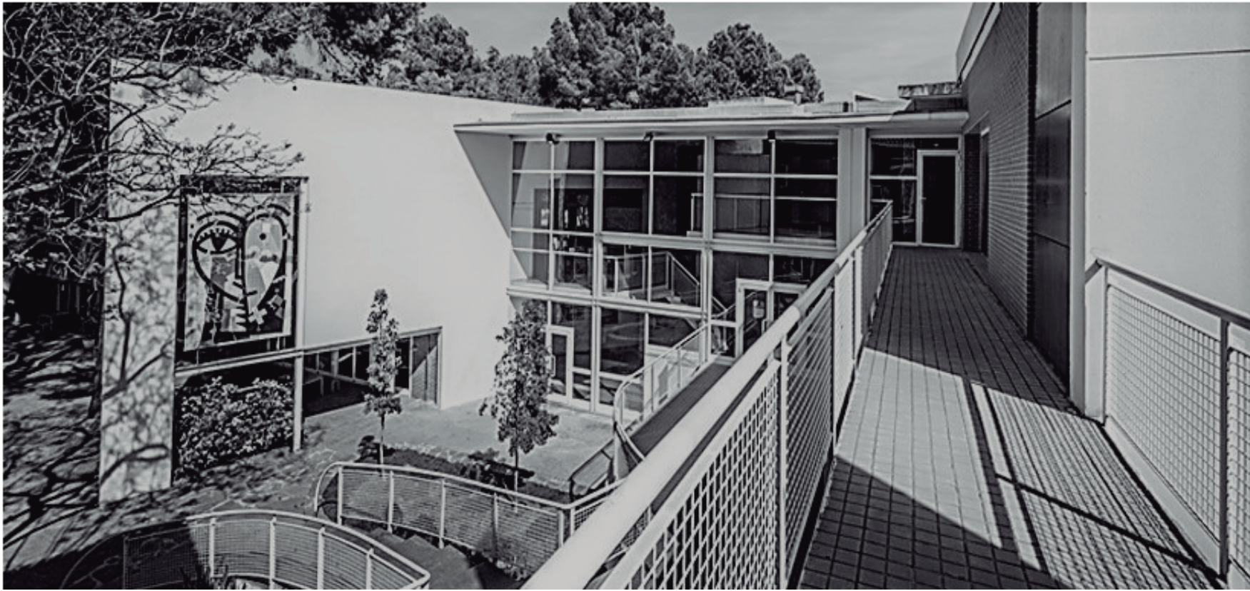
IMG 1: VISTA EXTERIOR
