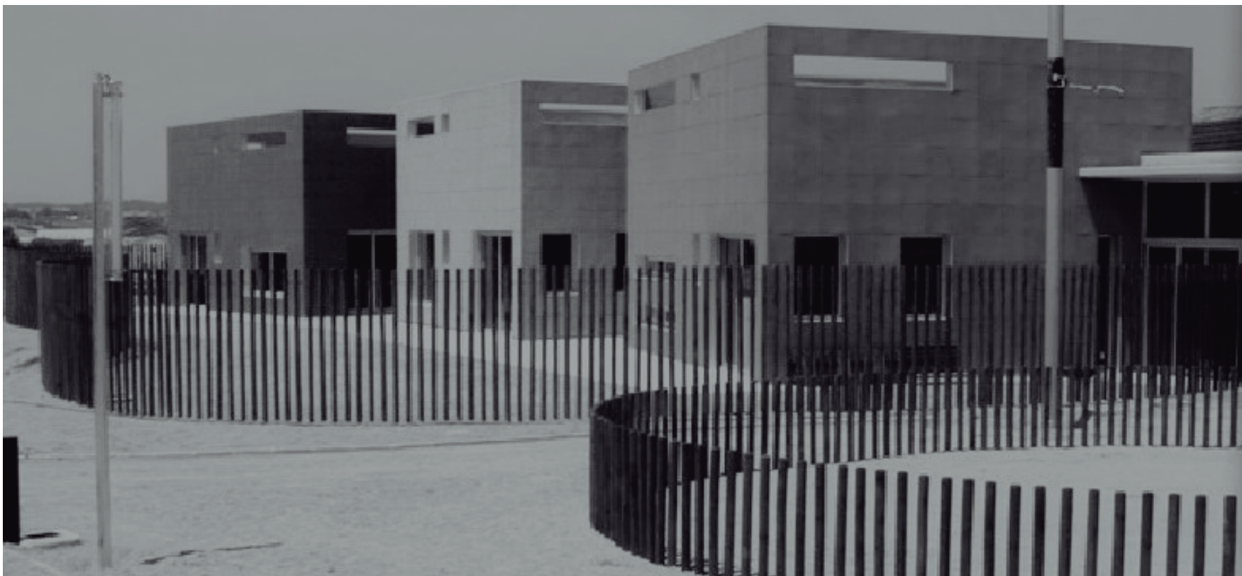
IMG 2: VISTA FACHADA LATERAL DERECHA
