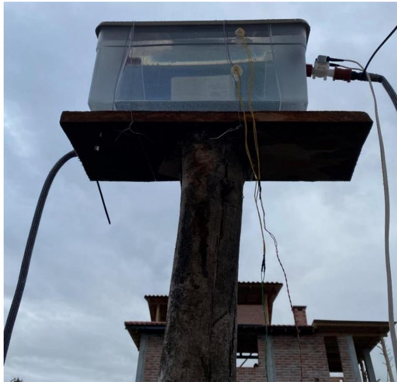
*Figura 32 Instalación del tanque almacenador de agua.*
