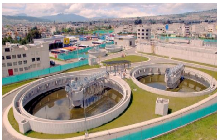
Figura 2.7. Tanques circulares sedimentadores de hormigón armado Fuente: Planta de tratamiento de aguas residuales Quitumbe, 2017
