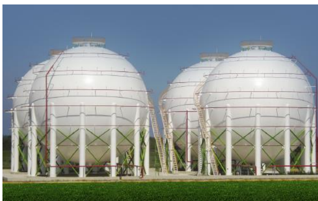
Figura 2.3. Tanque rectangular de láminas de acero inoxidable Fuente: Los tanques esféricos pueden trabajar a temperatura ambiente o semi refrigerados dependiendo de la necesidad de almacenamiento (Arcosa, 2021)
