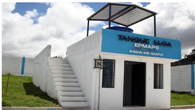
Figura 2.5. Tanque rectangular de hormigón armado enterrado. Fuente: Tanque de Almacenamiento de Uyachul, Pichincha, Quito 2021
