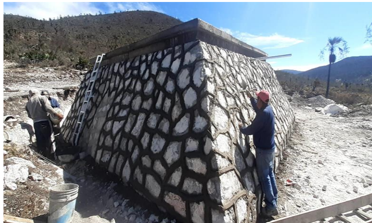
Figura 2.8. Tanque de mampostería de piedra Fuente: Tanque de almacenamiento de agua de Atexcal, México, (Uno, 2021)
