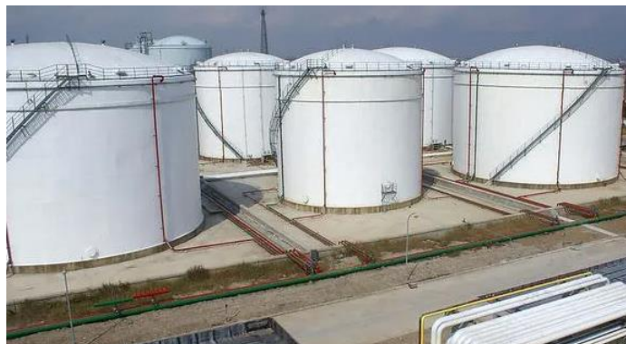
Figura 2.1. Tanque cilíndrico de acero al carbono o acero inoxidable Fuente: Tanques cilíndricos para almacenamiento de agua, petróleo o petroquímicos, China 2006
