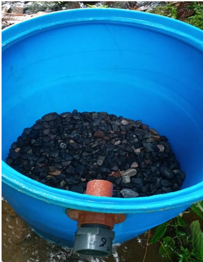
Fotografía N° 23 Capa de grava fina.
