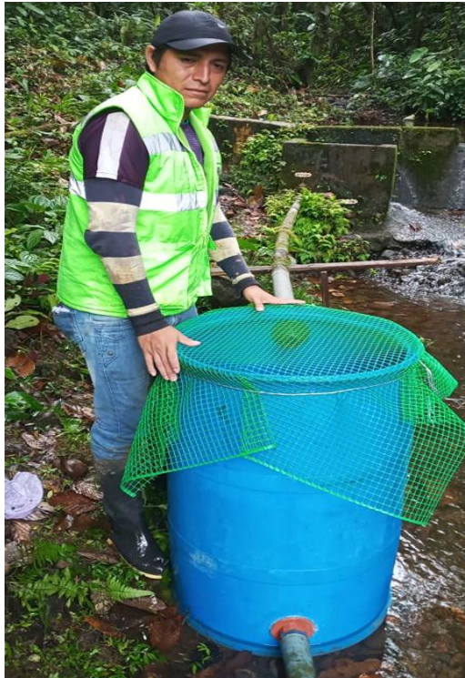
Fotografía N° 29 Implementaciones malla de polipropileno.
