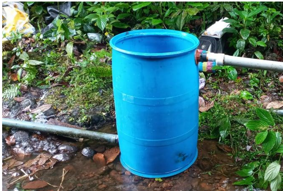
Fotografía N° 28 Instalación de tubería de salida.
