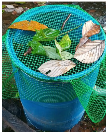
Fotografía N° 1 Malla de polipropileno, evitando el paso de vegetación.
