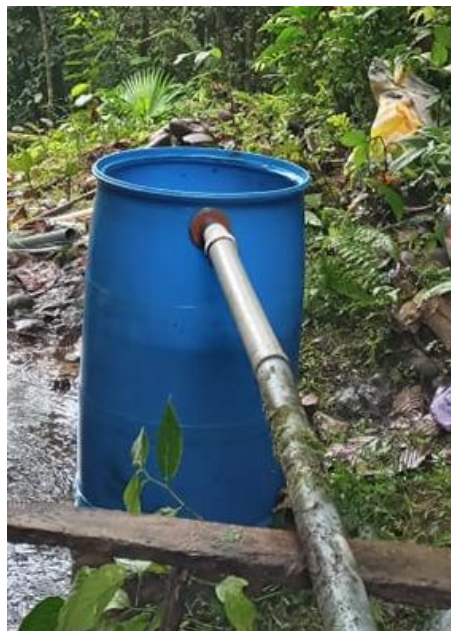
Fotografía N° 26 Instalación de tubería de entrada.
