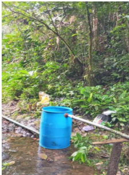
Fotografía N° 5 Instalación del filtro en el lugar adecuado.
