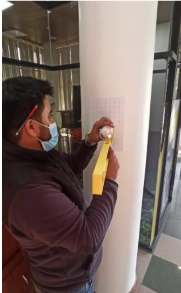
Ensayo Esclerométrico Columnas
