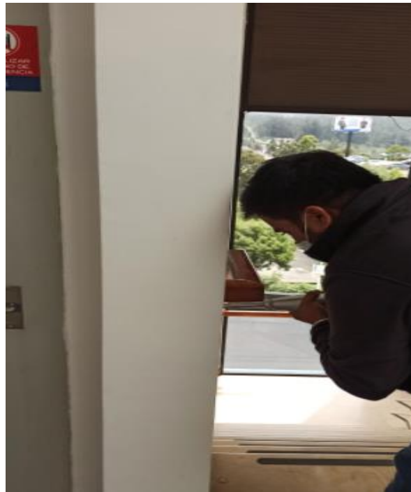
Ensayo Esclerométrico Columnas
