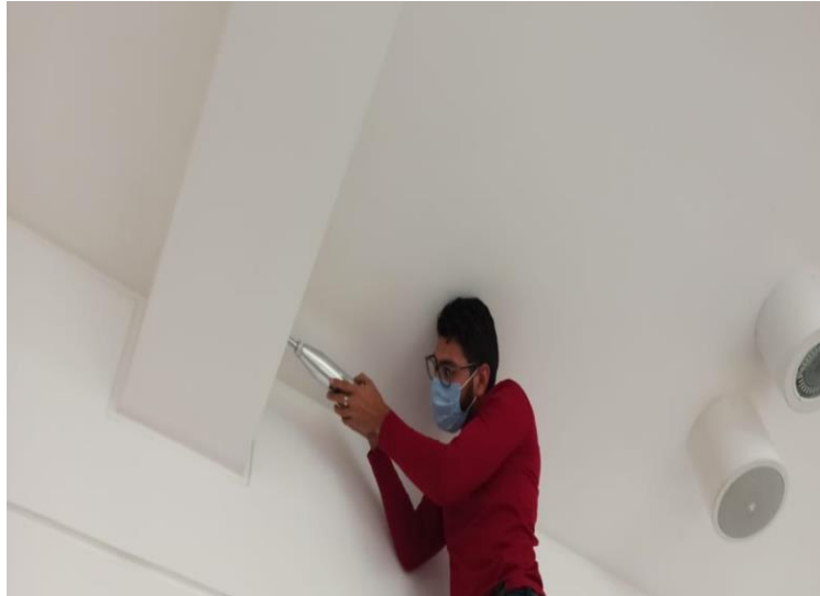
Ensayo Esclerométrico Vigas
