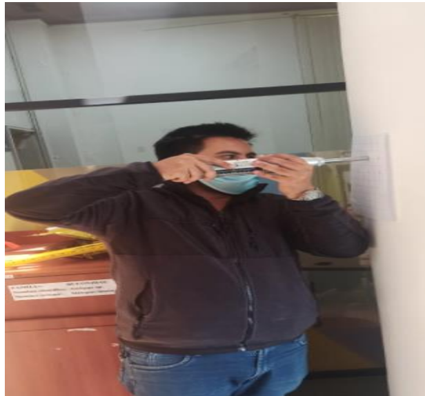
Ensayo Esclerométrico Columnas
