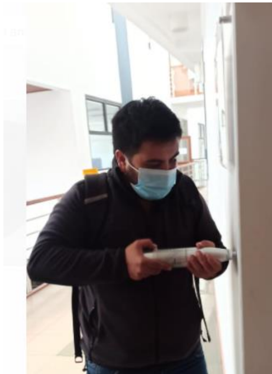
Ensayo Esclerométrico Muros
