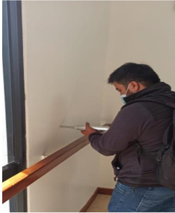
Ensayo Esclerométrico Muros
