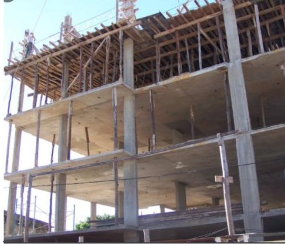
FIGURA 9 Sistema de vigas banda.
