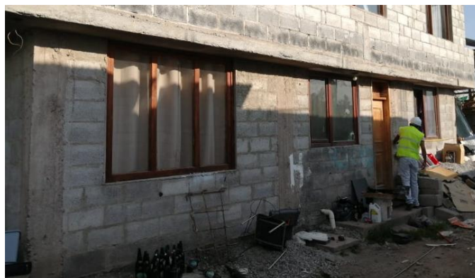
FIGURA 40 Fachada frontal de la vivienda en estudio. FUENTE: (Paucar, 2021).
