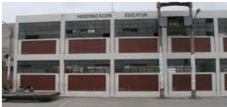
FIGURA 13 Presencia de Columna corta.
