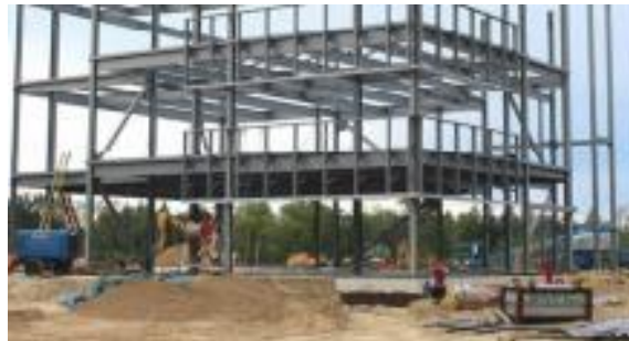
FIGURA 11 Sistema de estructuras metálicas.
