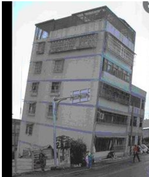
FIGURA15 Presencia de torsión en planta en edificación. FUENTE: Magenes+de+torsion+en+planta+en+construcciones, 2016.
