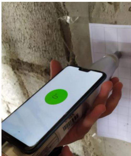
FIGURA 47 Ensayo con esclerómetro.
