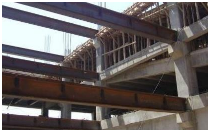
FIGURA 12 Sistema de estructura mixta.
