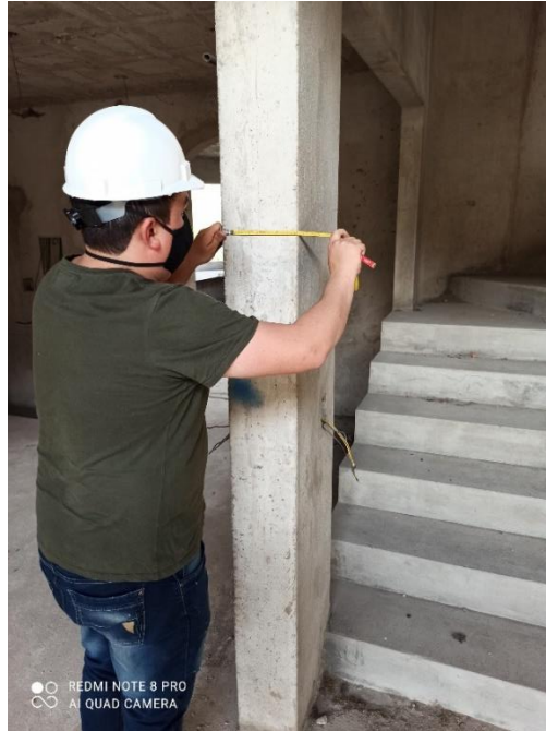
Figura 112 Medición de elementos estructurales
