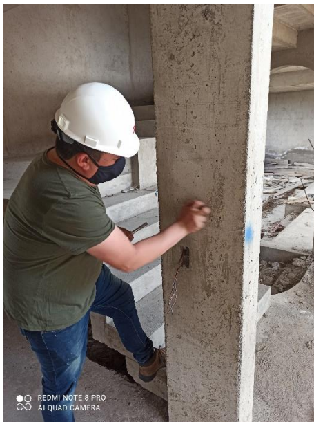
Figura 109 Limpieza de Superficie
