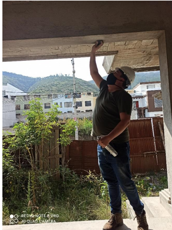
Figura 110 Limpieza de elementos estructurales 2
