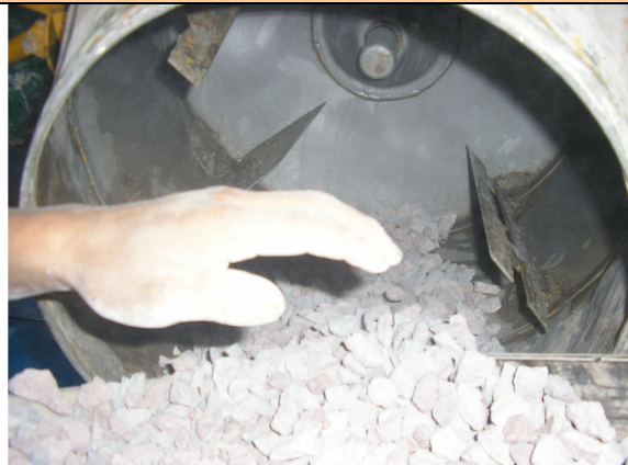
Foto 18: Colocación de los componentes del mortero de hormigón
