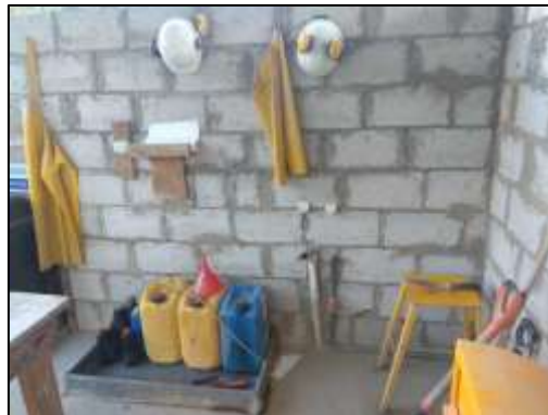
Fotografía 10 Almacenamiento de gasolina sin cierre perimetral , con cubeto de contención Fuente: Empresa Brown Rock Resources S.A
