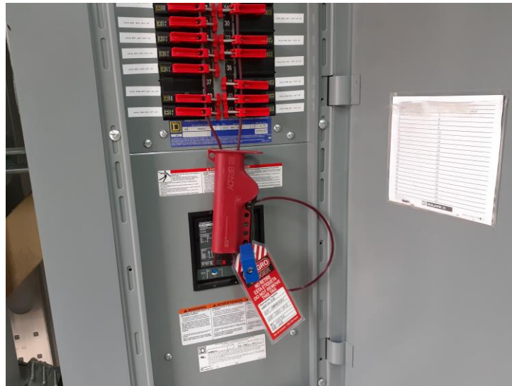
Imagen 4. Ejemplo de bloqueo con etiqueta y candado
