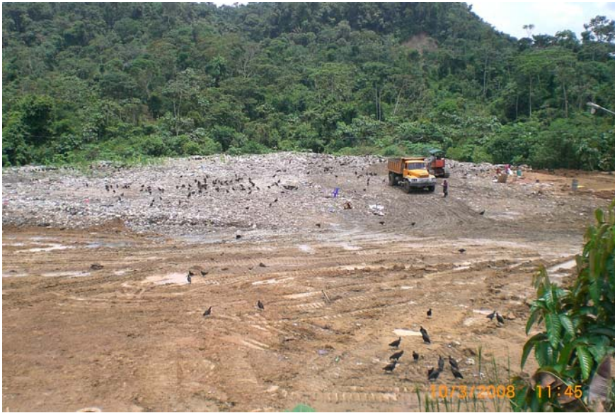
Foto 1. Vista Superficial del Relleno Sanitario
