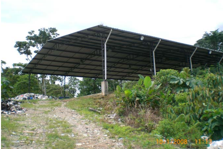
Foto 3. Cubierta para residuos sólidos clasificados
