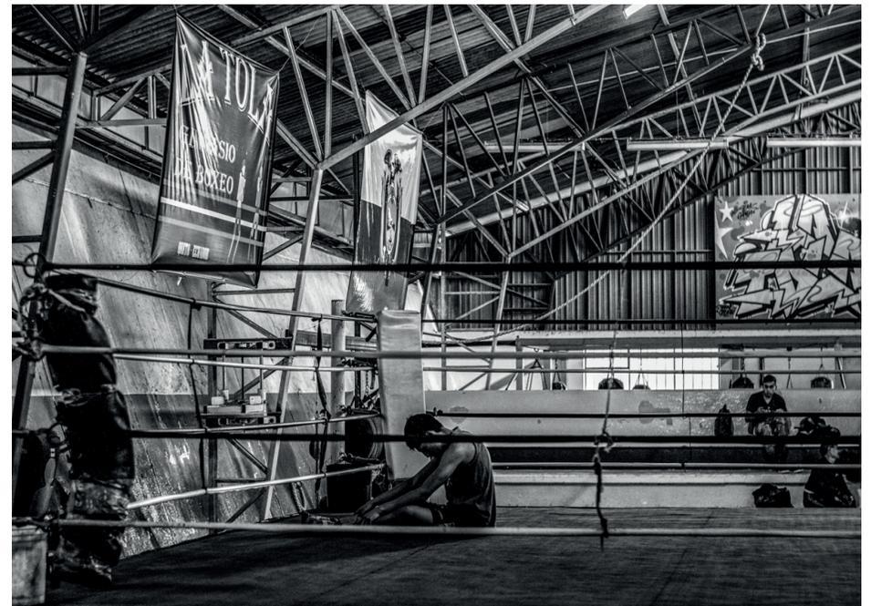
La estructura consta de una serie de cerchas metálicas vistas a dos aguas con cimientos de concreto, el volumen está conformado por paredes de bloque y cubierta de zinc acanelado en mal estado. La exposición de dichos elementos facilitan su rápido deterioro y daña la imagen general del proyecto.
