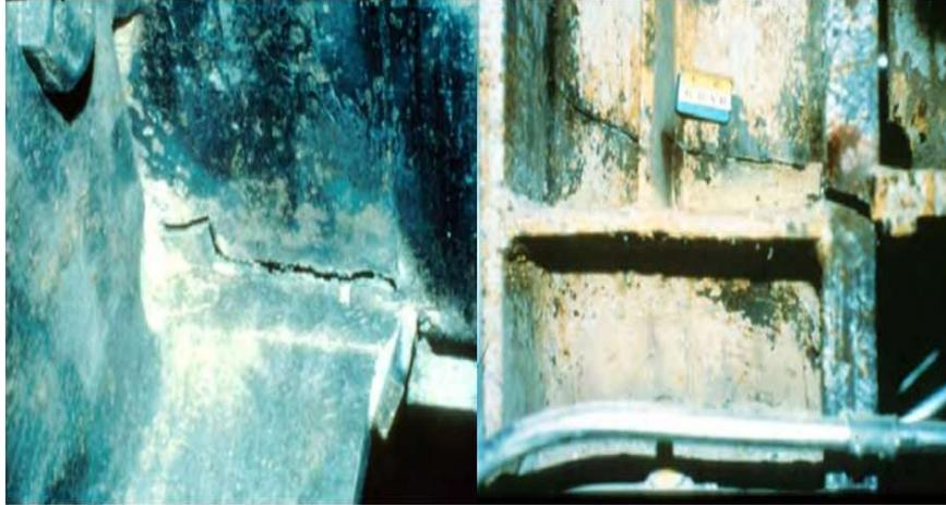
*Figura 12. Fractura en junta viga-columna y fractura en columna*
