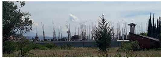
Imagen 6: Construcción Elaboración propia
