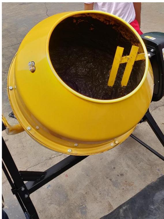
Figura 11. Mezclado del suelo-cemento plástico.
