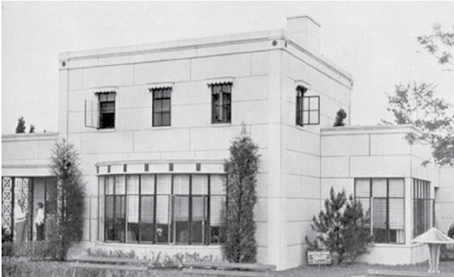
Imagen Nro. 58. *Andino, E. (2020)*. Primera edificación en sistema constructivo liviano en seco, Stran-Steel. Fuente: Manual Técnico del Sistema Constructivo Liviano en Seco de Eternit 2013.
