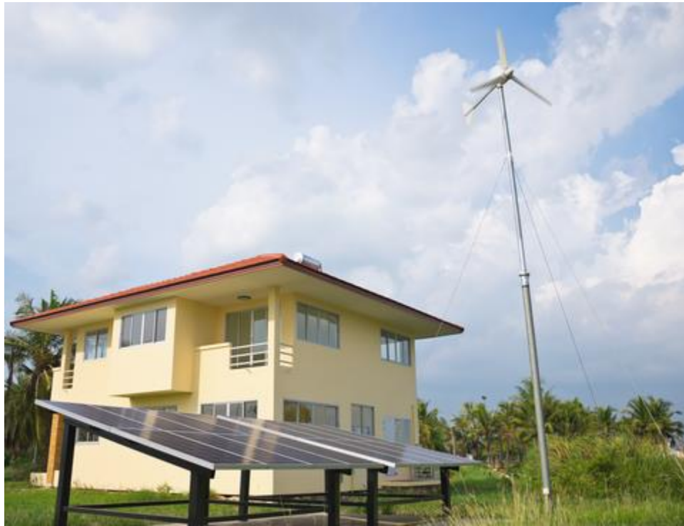
Ilustración 31 Vivienda autoabastecida mediante paneles fotovoltaicos y aerogeneradores
