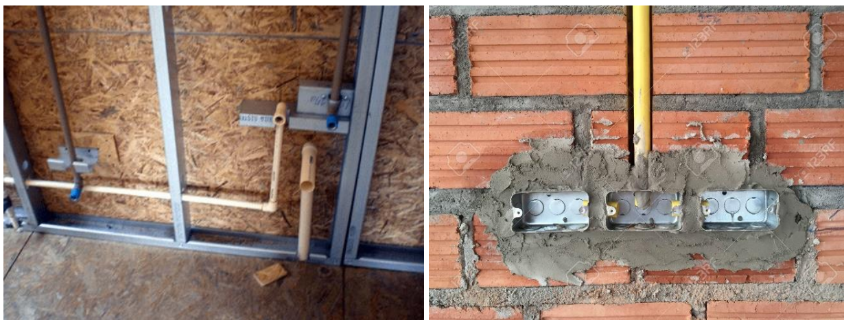
Ilustración 46 Instalaciones en Steel Frame y en ladrillo
