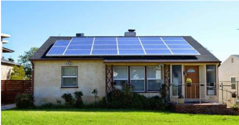
Ilustración 28 Vivienda con paneles fotovoltaicos
