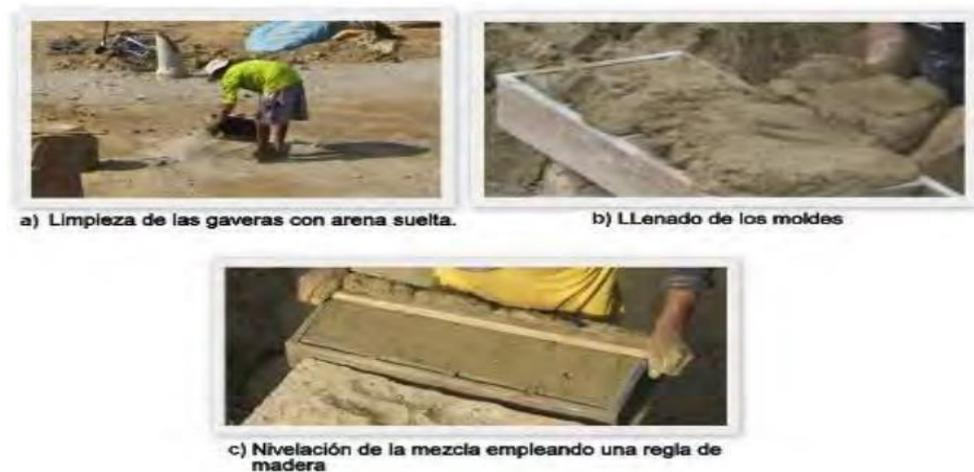
*Figura 4* Procesos de moldeado de ladrillos. (Lescano, 2014)
