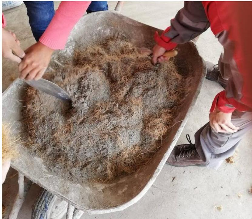
*Figura 63* Proceso de mezclado de arena y fibra de coco. (Autor)
