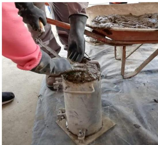
*Figura 28* Llenado de moldes con mezcla de hormigón. (Autor)
