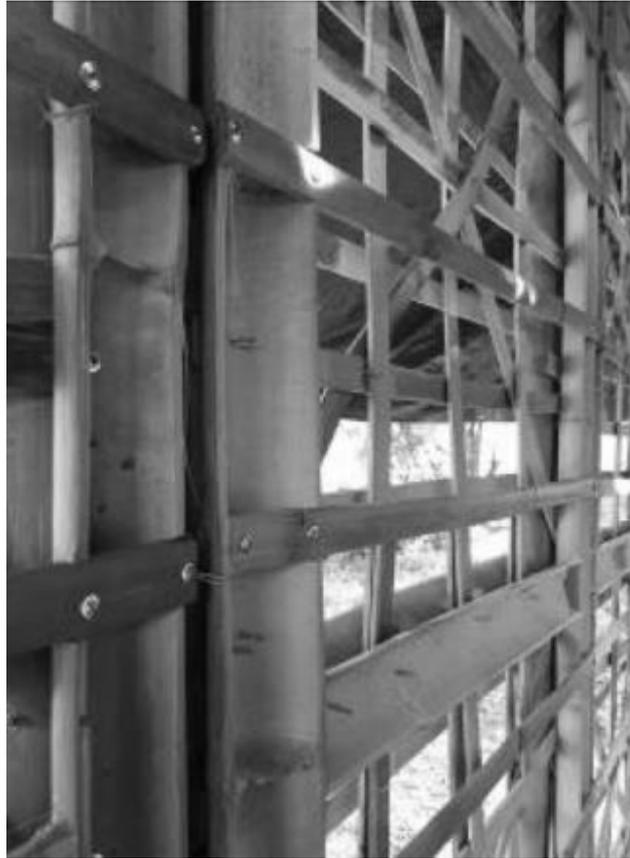
*Figura 2. Paneles prefabricados a base de polines de bambú ensamblados.*
