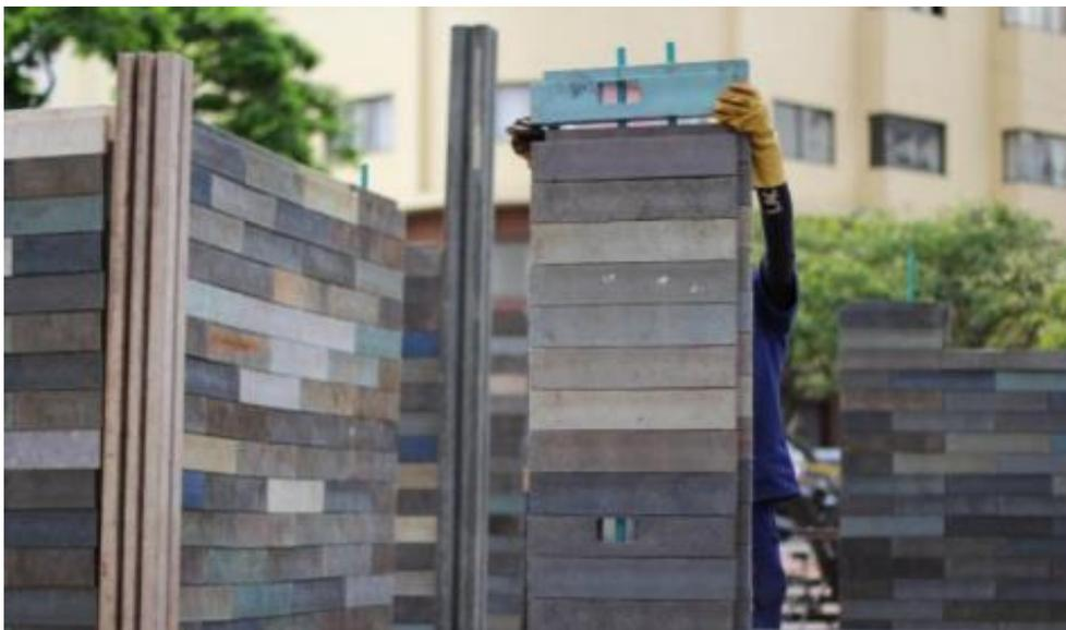
*Figura 3. Sistema constructivo de bloques y columnas de plástico extruido.*
