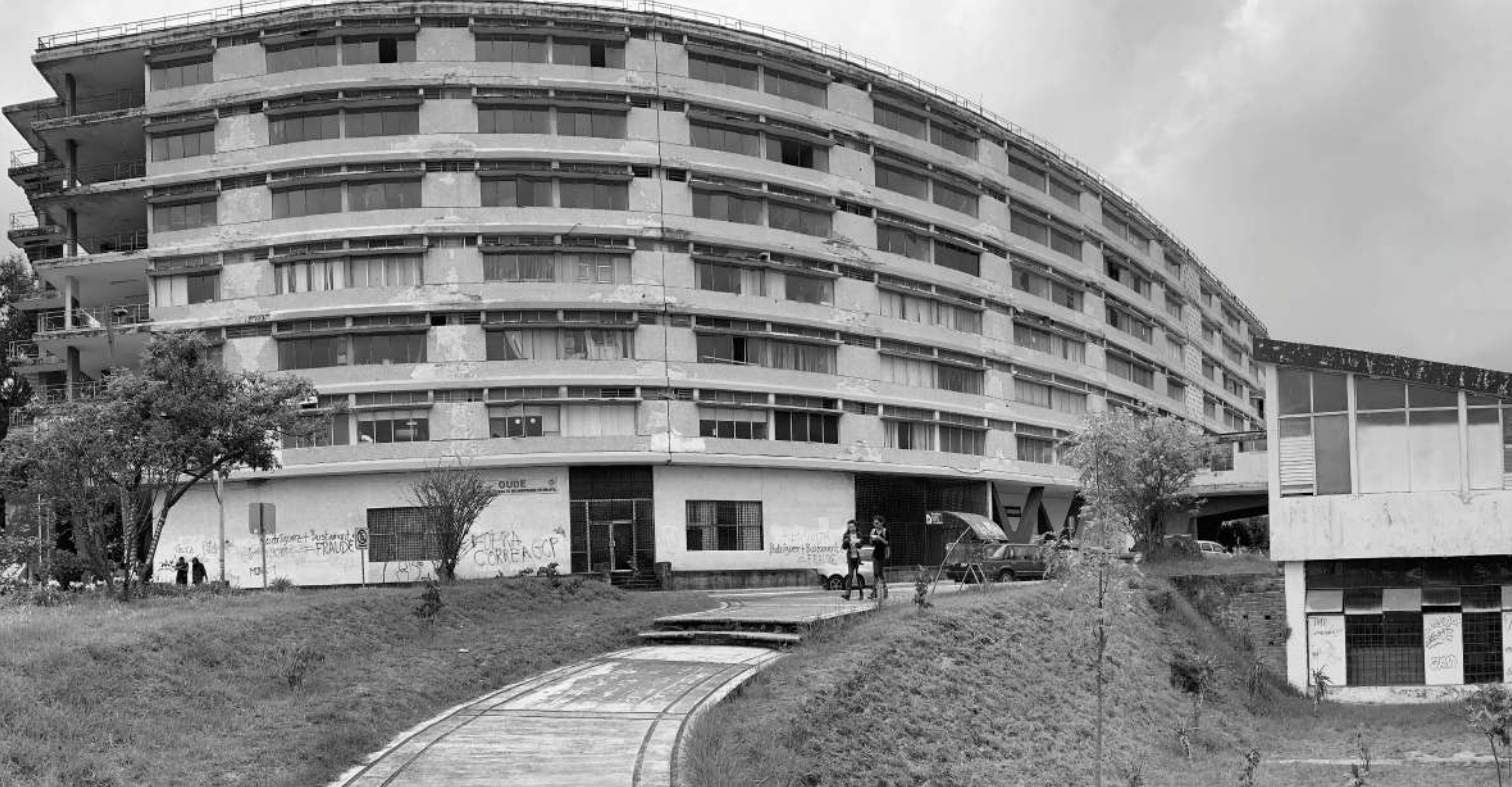
Figura 1: Fachada principal de la Residencia Universitaria de la UCE. Fuente: Realizada por la autora C.L.
